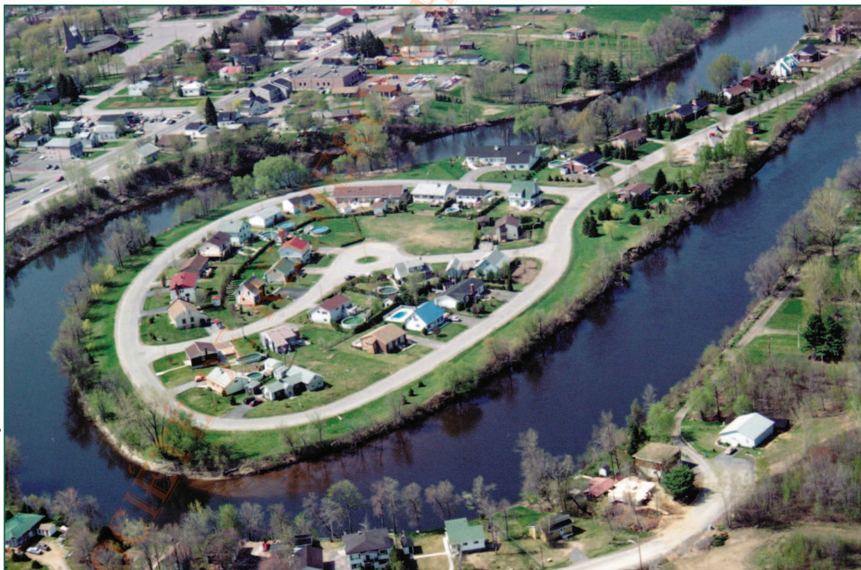
Vue aérienne du quartier résidentiel de la rue Louis-Bazin.
